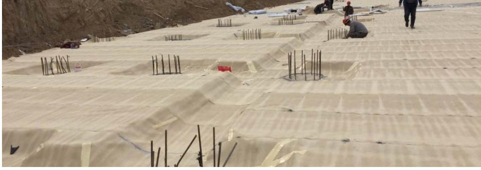
高铁站站前广场工程
