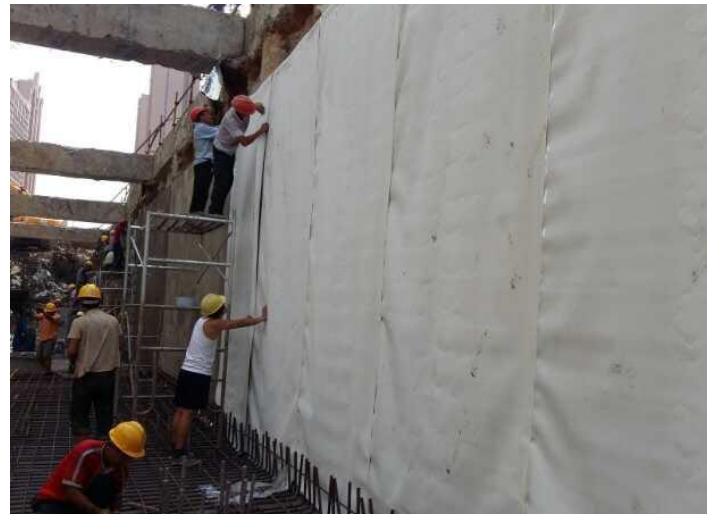
复合式侧墙基面处理
