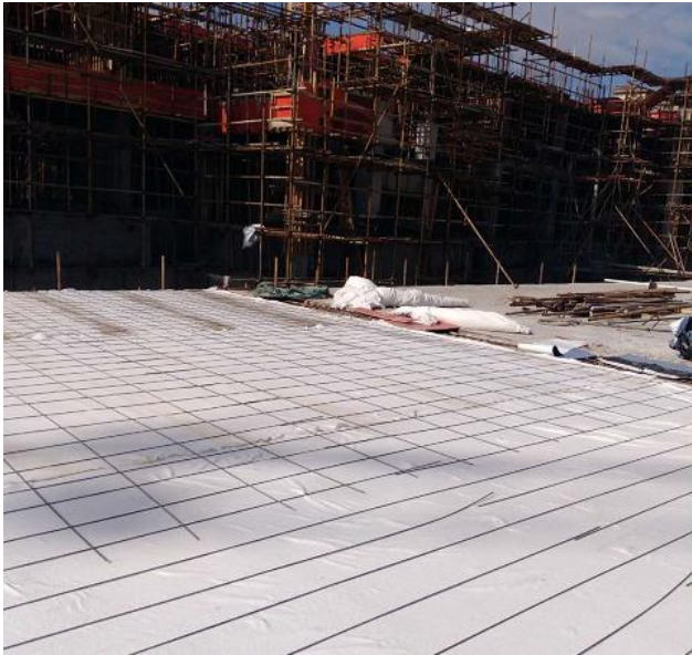
安置房项目工程
