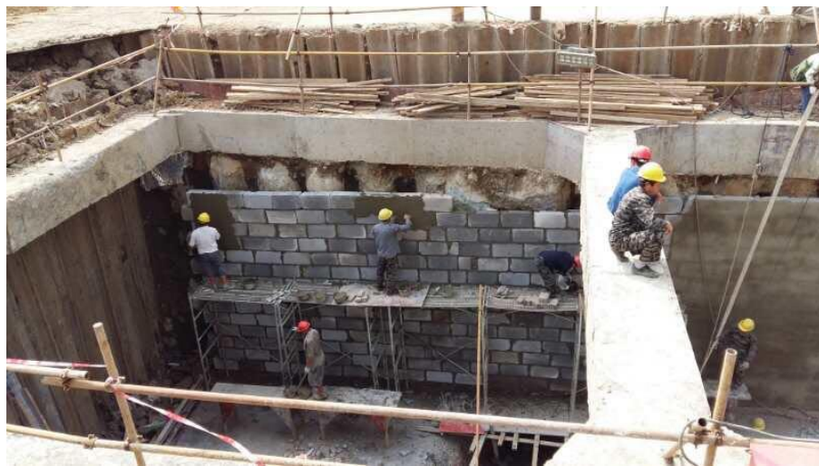
复合式侧墙基面处理
