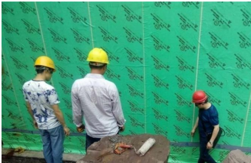
自粘法施侧墙工艺
